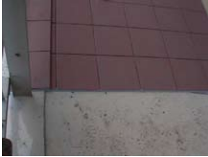
Tegels gelijmd met kit op een scheuroverbruggende coating.
